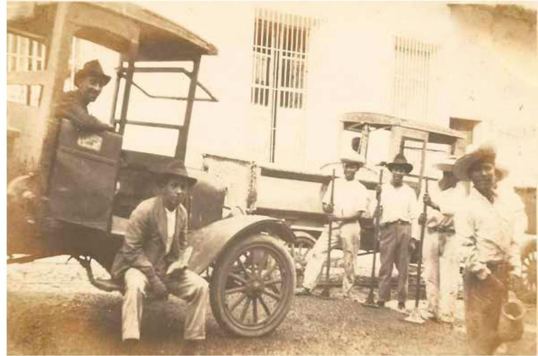
Primero vaciando su metro cúbico de asfalto; después, al finalizar la tarea descansan los operadores: el chófer y el encargado, con su libreta, los más abrigados en el primer carro; posando con sus pisonos de golpe junto a un segundo volteo están los tres operarios que descargaban el camioncito, y en la esquina derecha parece un aguador con su jarra.
